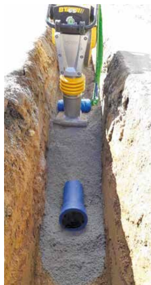
Remplacement des canalisations fuyardes de St Paul
