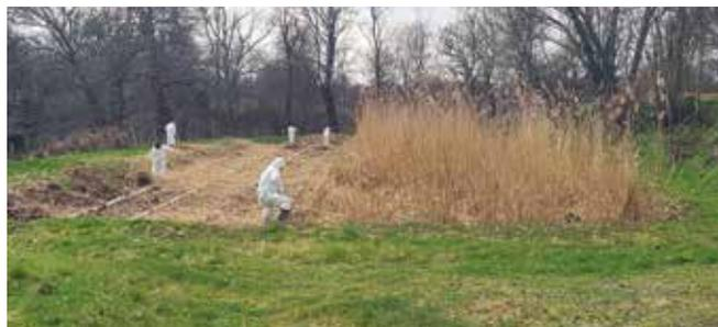
Le faucardage annuel de la station d'épuration consiste à couper les roseaux à environ 30/40 cm au-dessus du sol et à les extraire des filtres. Cette opération évite l'accumulation des roseaux et réduit ainsi l'épaisseur de boue à la surface des filtres. Afin de réduire la pénibilité de ces tâches et d'économiser du temps, la commune a fait appel comme tous les ans au chantier d'insertion du Relais d'Insertion Solidaire de Monts et Barrages.
