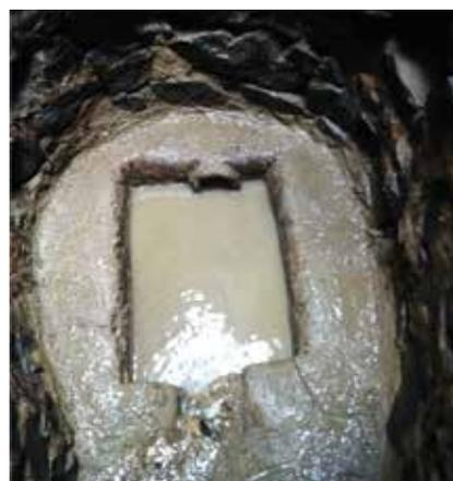
*Au fond d'un des puits, une conduite, remplacée par les agents de la commune, permet d'acheminer l'eau en direction du bourg. L'écoulement d'eau permanent permet d'éviter que les conduites se bouchent. La turbidité de l'eau en sortie, ou au lavoir, permet d'évaluer l'état du réservoir et du réseau. Ici, l'eau paraît trouble suite à notre présence, mais elle est habituellement claire.*
