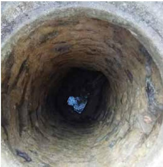
*L'entrée vers le captage se fait par un puits maçonné de plusieurs mètres. De part et d'autre on aperçoit les encoches destinées à y mettre ses pieds afin de descendre.*
