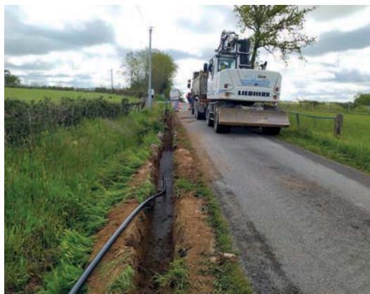
Mise en place d'une conduite d'eau en direction de Nontyon
