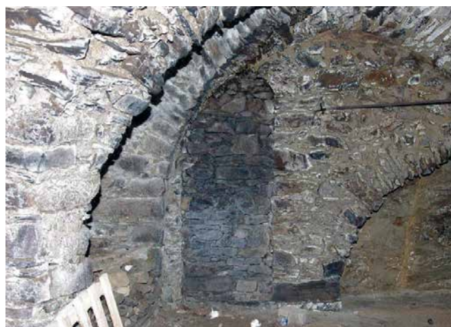
Départ de souterrain muré, sous l'ancien presbytère, perpendiculaire au précédent.
