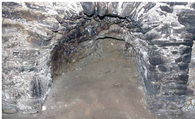
Départ de souterrain remblayé, qui s'enfoncé. Sous l'ancien presbytère, direction l'église.
