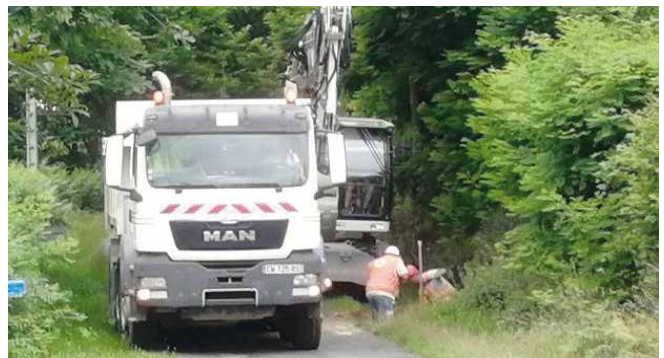
Creusement de fosses aux Rouchilloux afin de permettre la mise en place de la nouvelle canalisation par éclatement.
