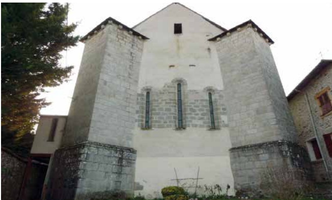
Chevet de l'église : Les contreforts carrés constituent de véritables tours d'angle, avec des corbeaux en quart de rond qui ont dû supporter un hourdage.
