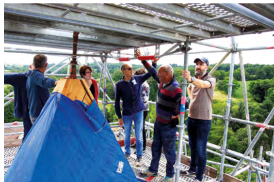
Visite guidée du chantier pour les élus par M. Martinet et le chef de chantier.
