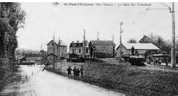
La gare de Saint-Paul avec sa zone de chargement et déchargement derrière.
