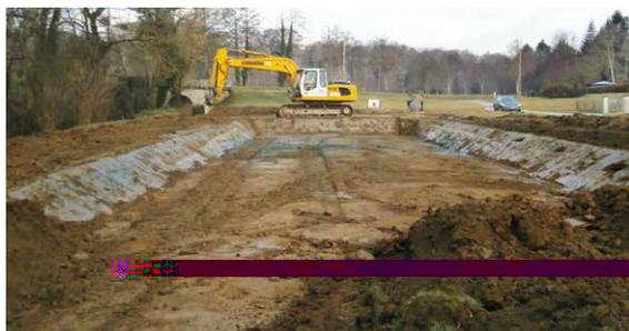
Des travaux très importants avaient été réalisés sur l'étang communal à partir de 2010, cependant la mise aux normes du système de vidange n'avait pas été faite. Un arrêté préfectoral de 2012 pointait la non-conformité du dispositif de vidange et mettait en demeure la commune de faire les travaux nécessaires. Avec l'appui du bureau d'études GEONAT, les travaux ont été effectués au printemps par l'entreprise CMCTP de Saint-Laurent sur Gorre, pour un montant total de 18 000 € (bassin et clôture).
